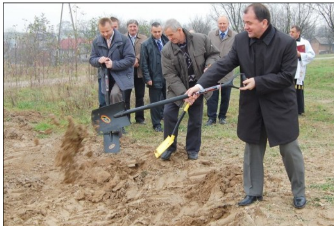
Pierwsze wykopy pod nową inwestycję
