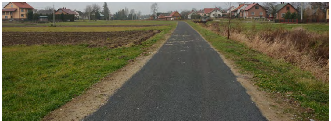
Drogi utwardzono poprzez skropienie emulsją asfaltową
