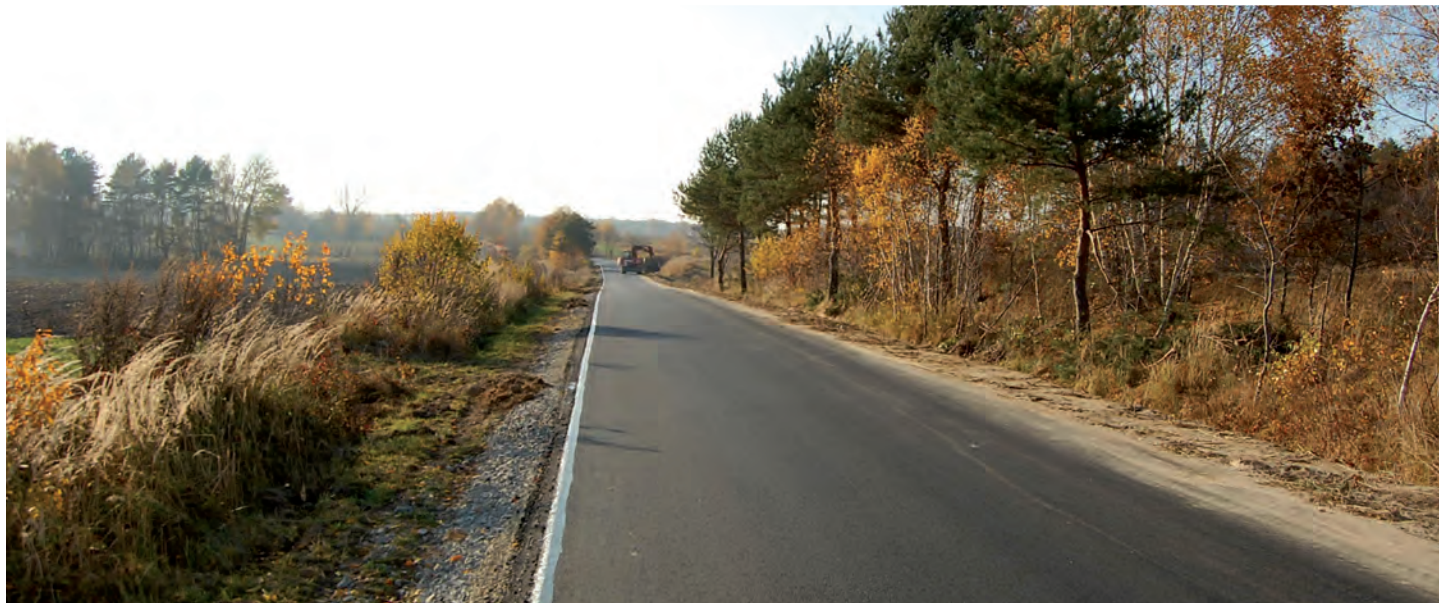
Kontynuacja odcinka drogi powiatowej żołyńskiej. Wykonawca: Przedsiębiorstwo Budowy Dróg i Mostów w Leżajsku
