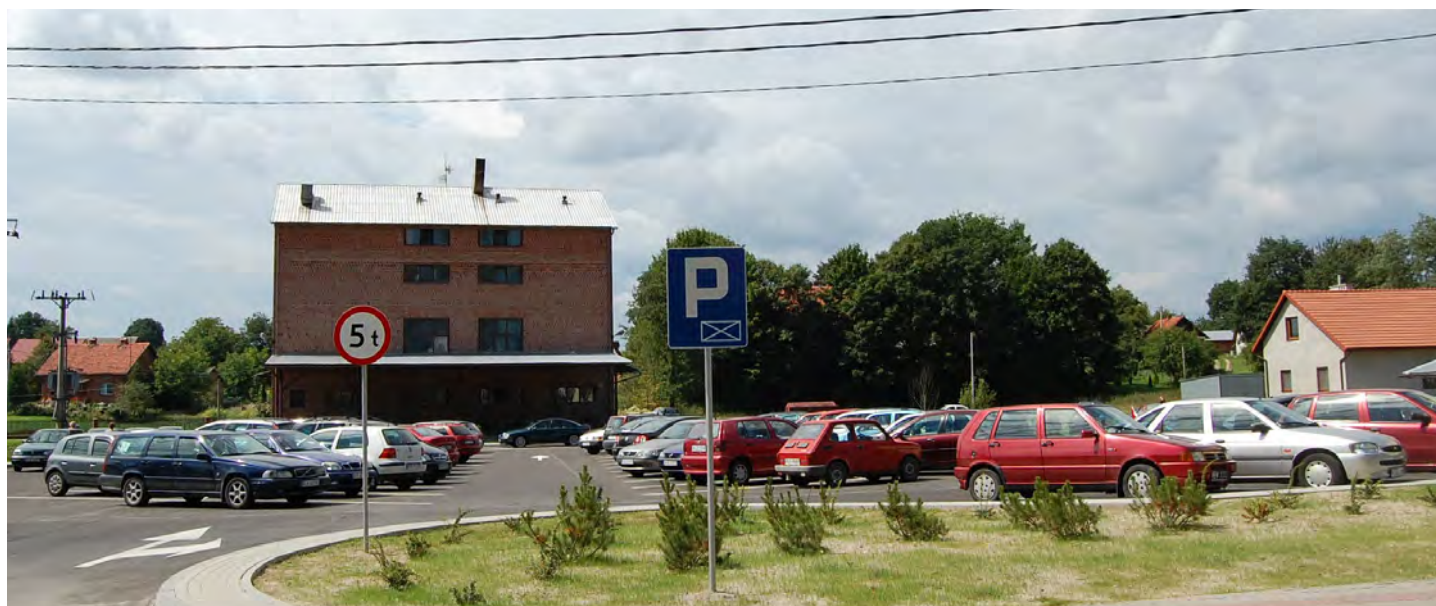
Parking przy kościele w Grodzisku Dolnym. Wartość inwestycji 414 646 zł. Dofinansowanie: 245 700 zł. Wykonawca: SUDR w Grodzisku Dolnym
