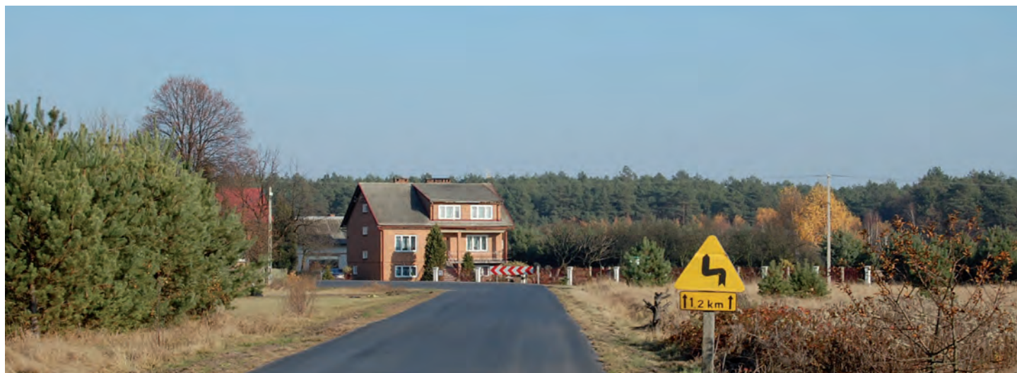
Laszczyny-Budy Łańcuckie, zakręt na „Wesołej”. Wykonawca: Przedsiębiorstwo Budowy Dróg i Mostów w Leżajsku
