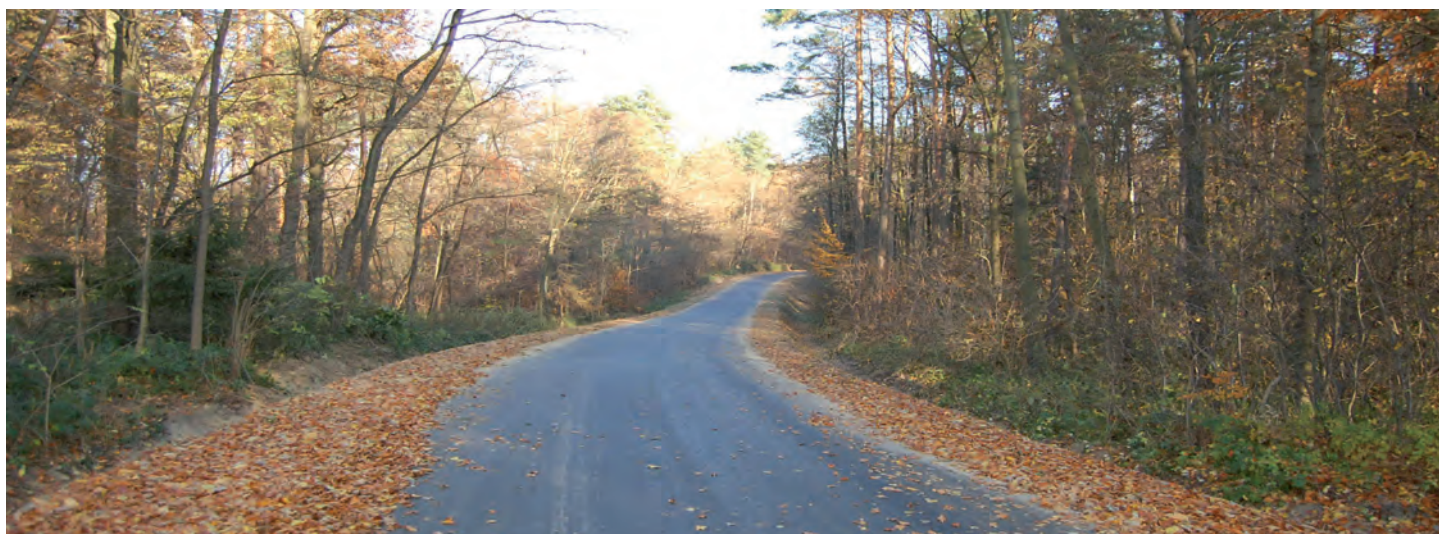
Odcinek drogi żołyńskiej na p. Maja. Wykonawca: Przedsiębiorstwo Budowy Dróg i Mostów w Leżajsku
