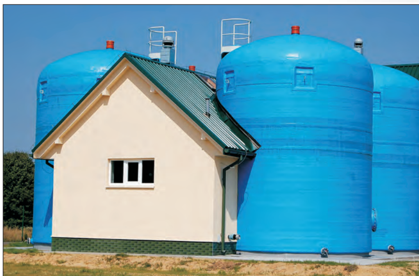
Oczyszczalnia ścieków w Chodaczowie
