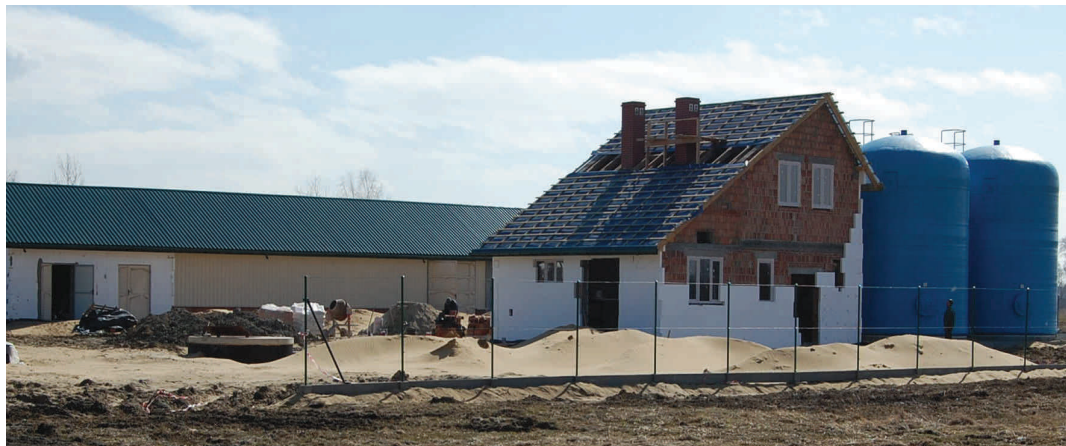
Kontynuowane prace przy oczyszczalni ścieków w Chodaczowie
