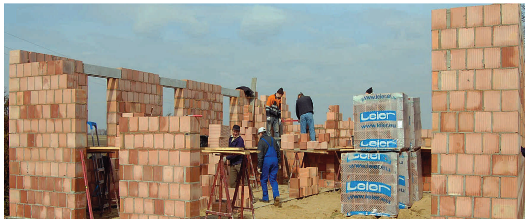
Strażacy z OSP Grodzisko Nowe przy budowie swojej remizy
