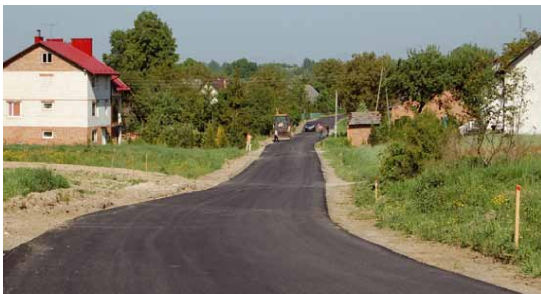
Remont drogi „Na Góry”
