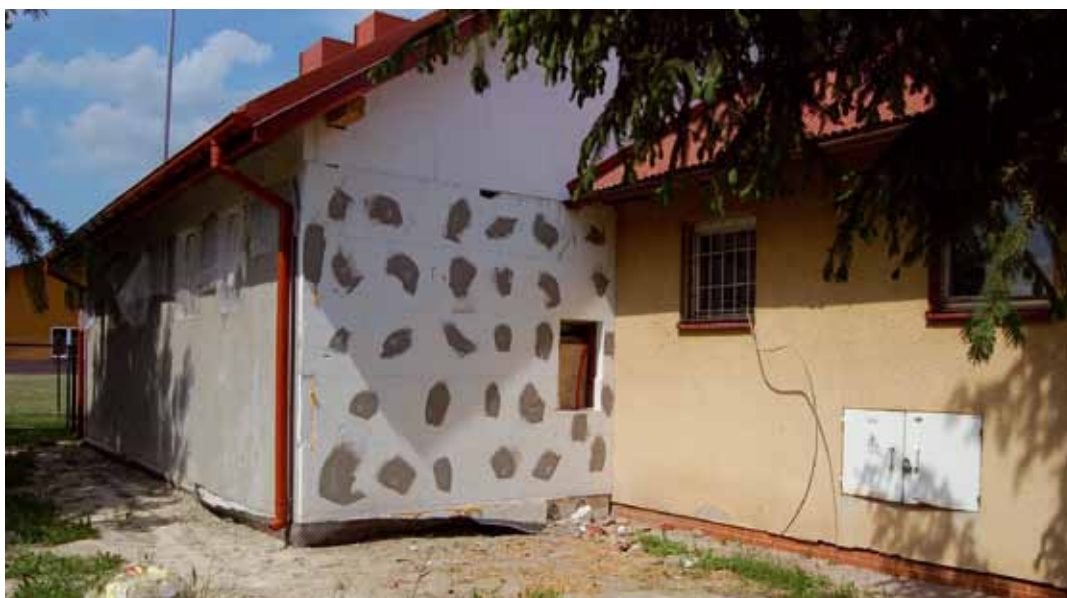
Na oczyszczalni w Grodzisku Dolnym zamontowano zbiornik stabilizacji osadu
