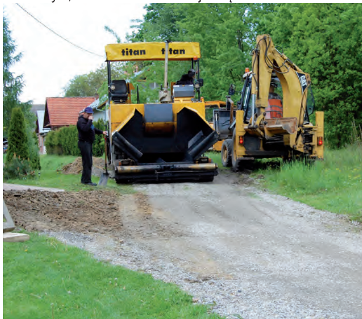
SUDR rozpoczął już prace na drogach gminnych
