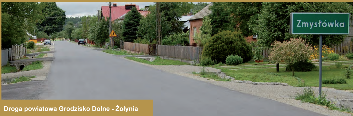
Droga powiatowa Grodzisko Dolne - Żołyńia
