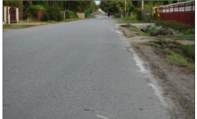
Droga G. Nowe-Chodaczów
