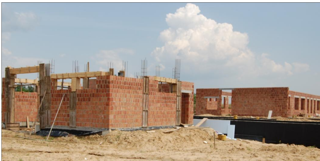
Plac budowy w Wólce Grodzkiej
