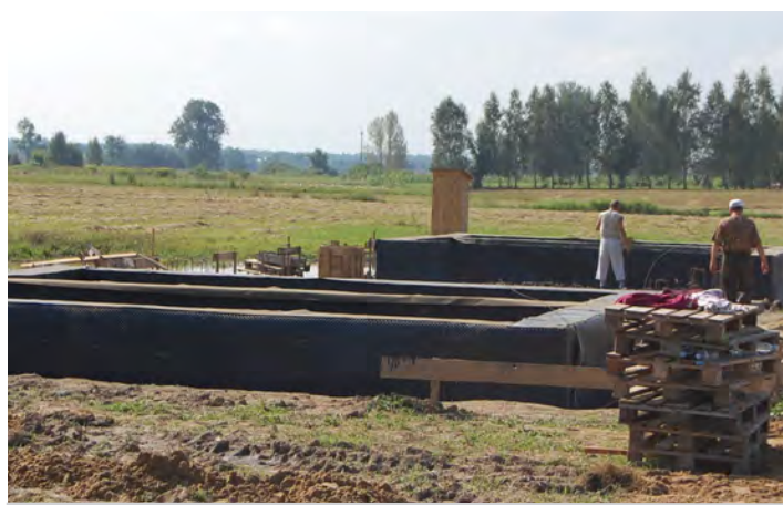
Nowa oczyszczalnia ścieków w trakcie budowy
