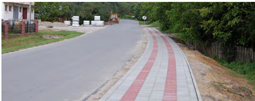
Budowa chodnika na odcinku „Czyste” - Czerwona Kapliczka
