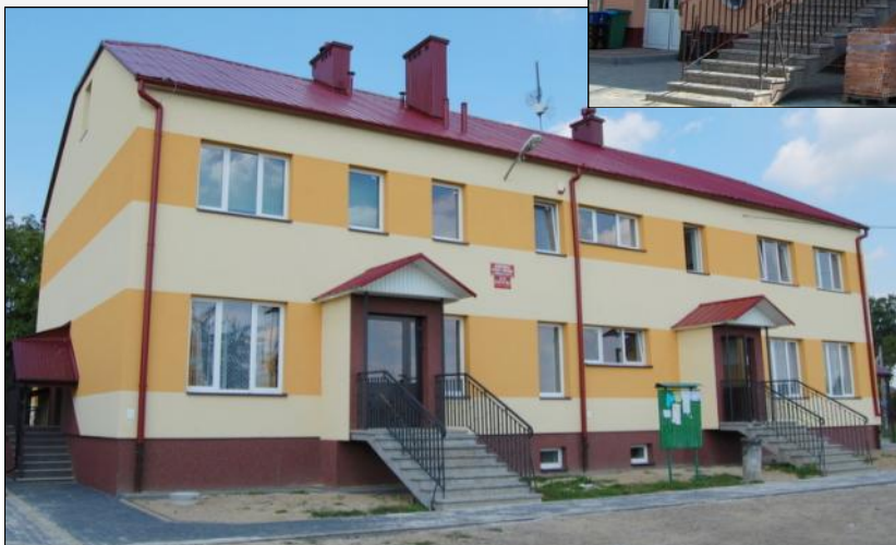
Wyremontowany Budynek Wiejski w Grodzisku Nowym
