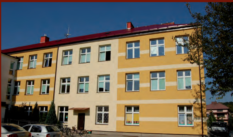
Nowa elewacja na szkole w Grodzisku Dolnym - widok od strony parkingu
