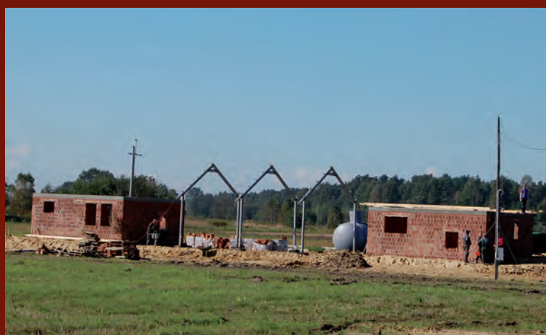
W Chodaczowie powstaje nowoczesna oczyszczalnia ścieków
