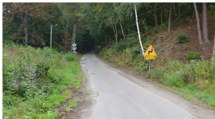
Przygotowywana do remontu droga „Na Zaborcze”
