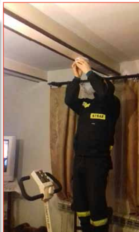
Montaż detektorów w Laszczynach
