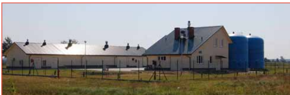
Do oczyszczalni w Chodaczowie trafiają ścieki z Grodziska Nowego i Chodaczowa
