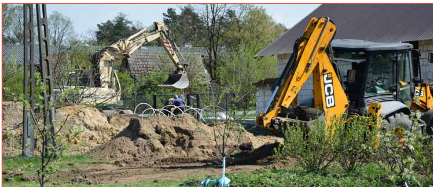
Prace przy budowie kanalizacji w Laszczynach
