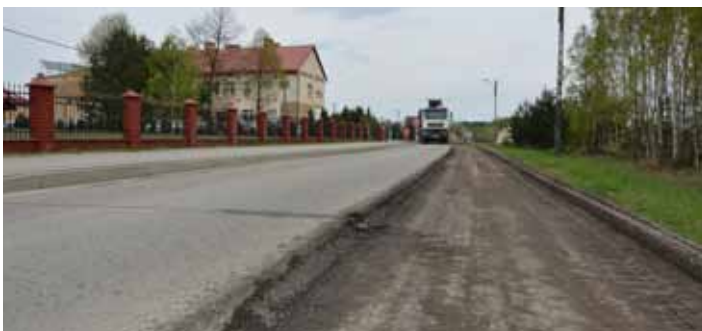
Ściągana nawierzchnia drogi w Laszczynach (fot. z dnia 19.04.2017r.)
