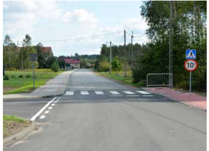
Bezpieczeństwo pieszych poprawią trzy przejścia
